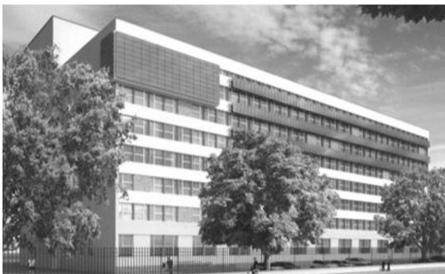
Rys. 4.12. Systemy fotowoltaiczne na fasadzie budynku Wydziału Inżynierii Środowiska Politechniki Warszawskiej
