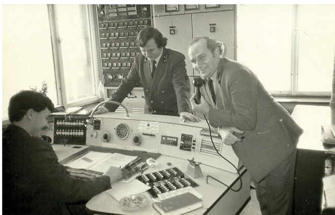
Dyspozytornia Ruch II Ignacy w kopalni „Rydułtowy” z 1970 roku
